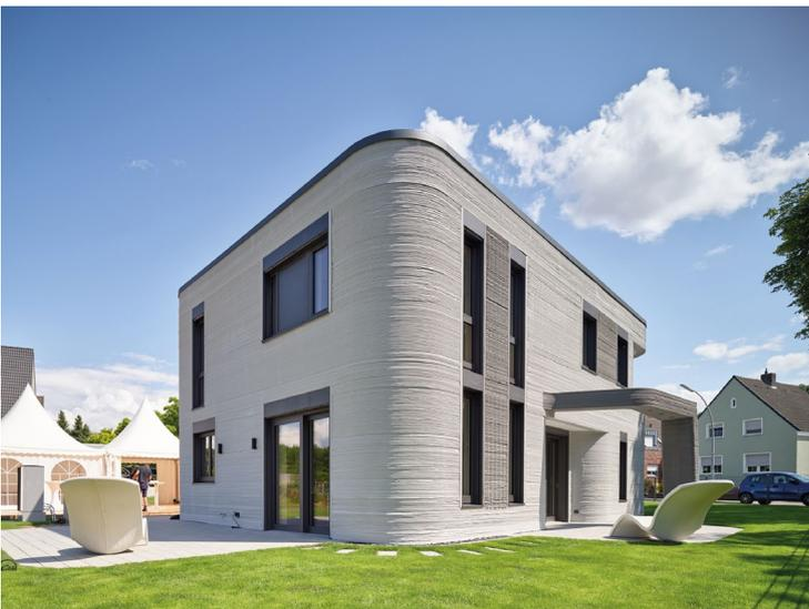
Das zweigeschossige Einfamilienhaus in Beckum wurde komplett im 3D-Druckverfahren erstellt und im Sockelbereich mit MB 2K abgedichtet.
